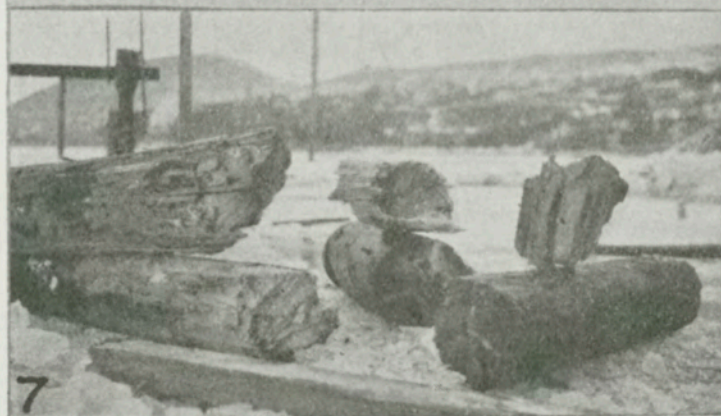
Fig. 5. Peling med damphammer. Fig. 7. Peler kappet ved sprengning.
